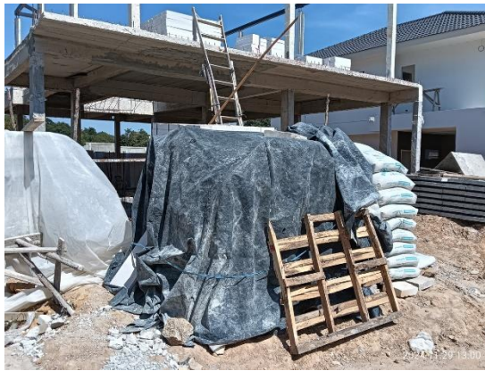
รูปที่ 3-7 ผ้าใบปิดคลุมวัสดุก่อสร้าง
